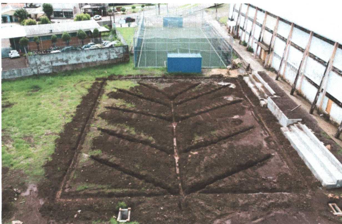
Foto 02: escavação de espinha de peixe
