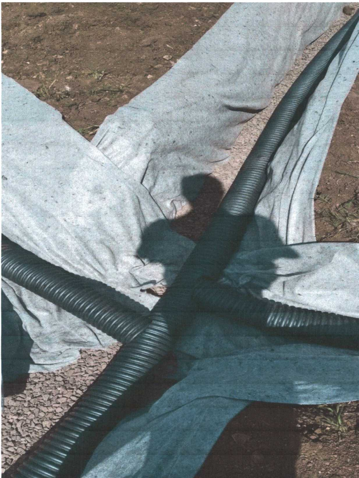
Foto 03: junção do ramal principal com os secundários
