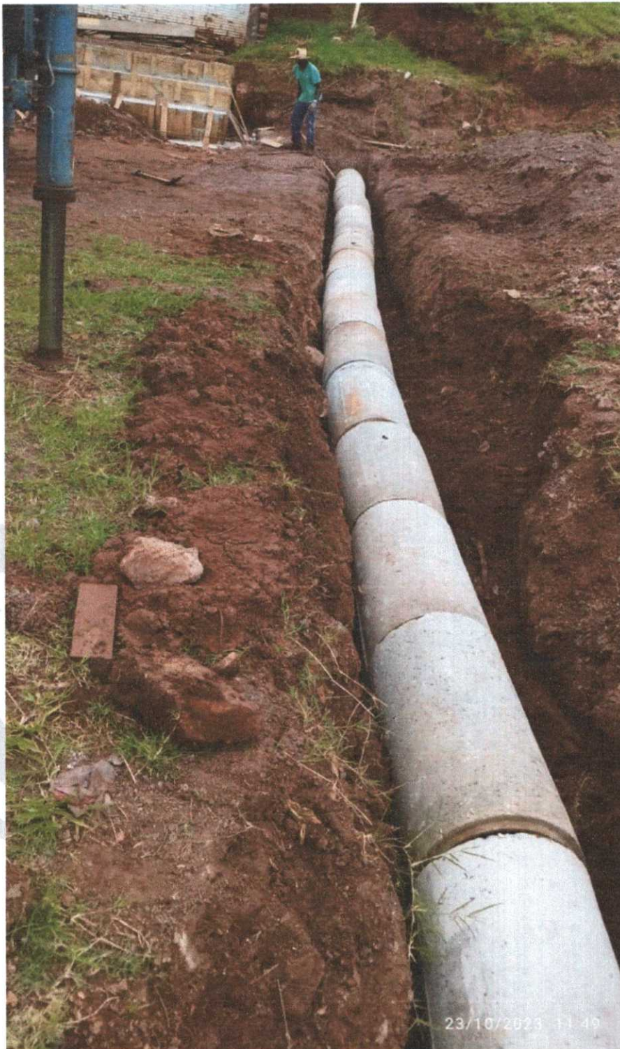
Foto do dia 23/10/23: instalados os tubos de concreto. (serviço não medido até o momento).
