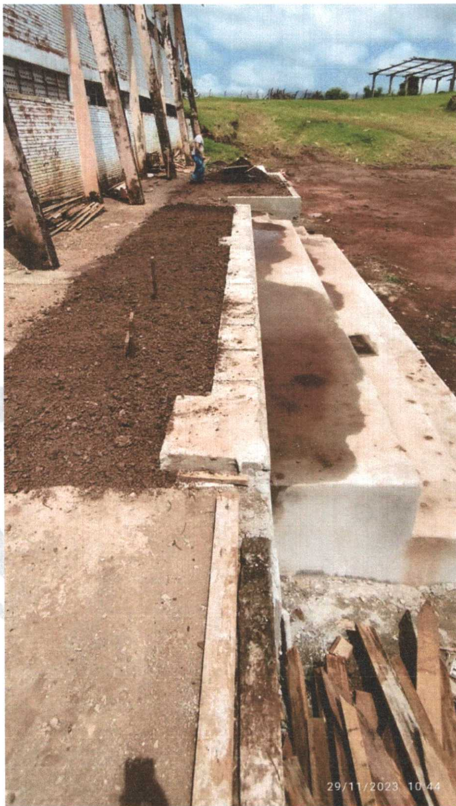
Foto do dia 29/11/23: Aterro para execução do piso entre a arquibancada e o ginásio, e o emboço da arquibancada. (Serviço não medido até o momento).
