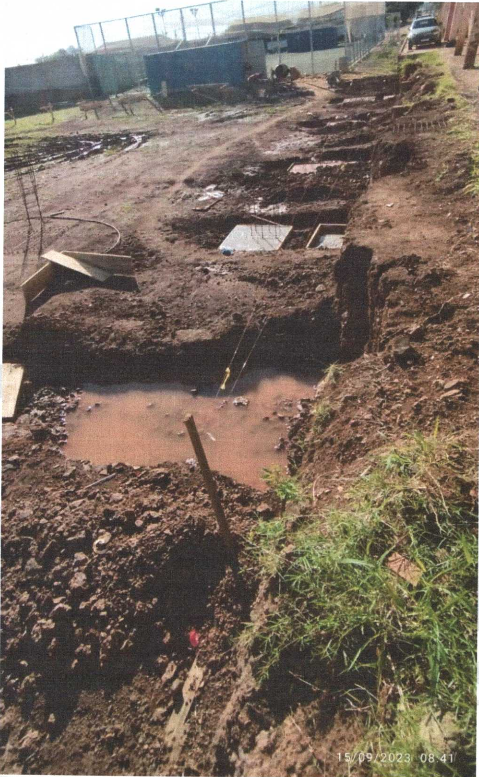
Foto do dia 15/09/223, com a fundação da arquibancada parte concretada e outra parte alagada.
